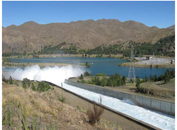
Lake Benmore Spillway
